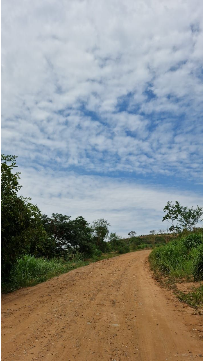
Foto 3: Trecho Estrada Tapuia
