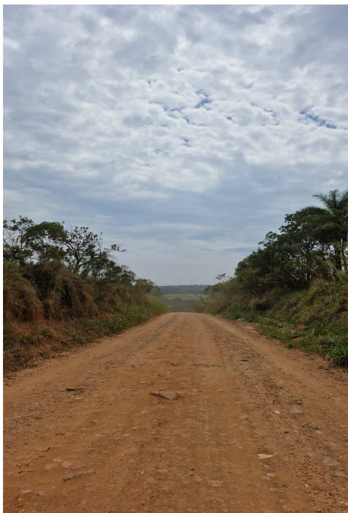
Foto 1: Trecho Estrada Tapuia
